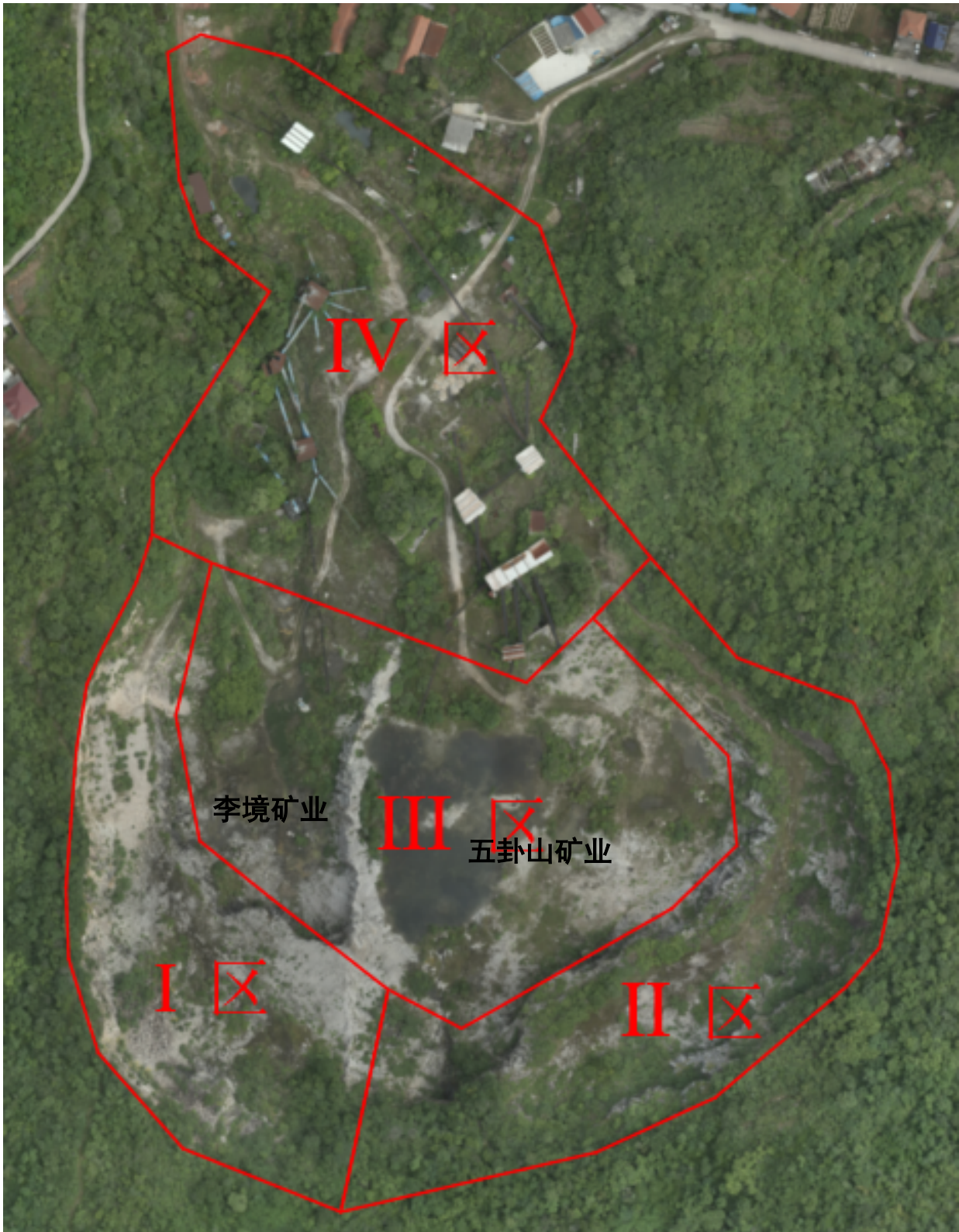
照片 4-1 矿山开采边坡全貌
