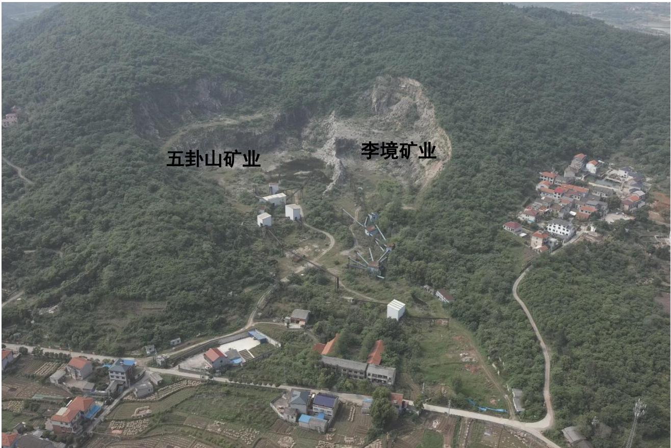
照片 4-2 矿山开采边坡全貌
